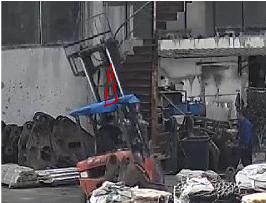
图四 视频截图偏斜的吊带
